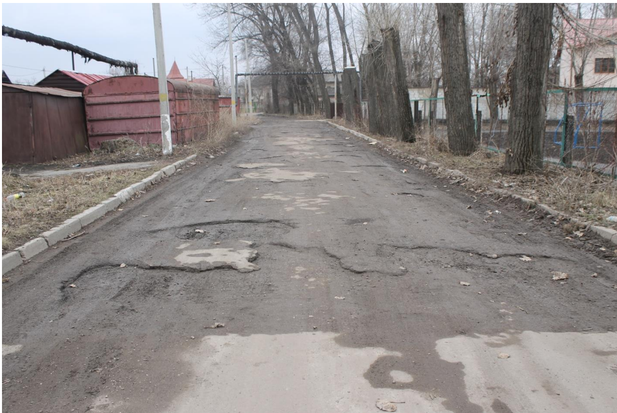
Imaginea nr. 13: Infrastructura rutieră și pietonală în ZR. Strada Petru Zadnipru Sursa: Vizite de observare (noiembrie – decembrie 2021)
