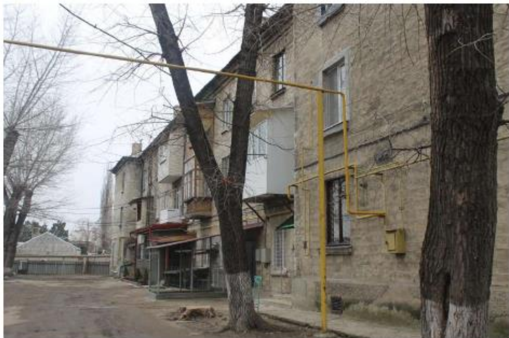
Imaginea nr. 14: Curtea blocului de locuințe din str. Kiev 50 Sursa: Vizite de observare (noiembrie - decembrie 2021)
