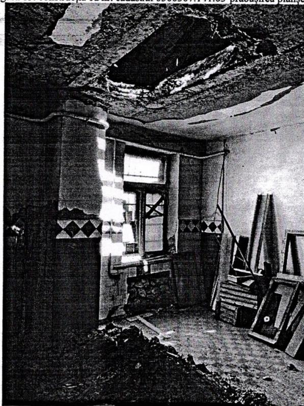
Figura 14. construcția cu nr. cadastral 0300307.141.03-zidărie necorespunzătoare
