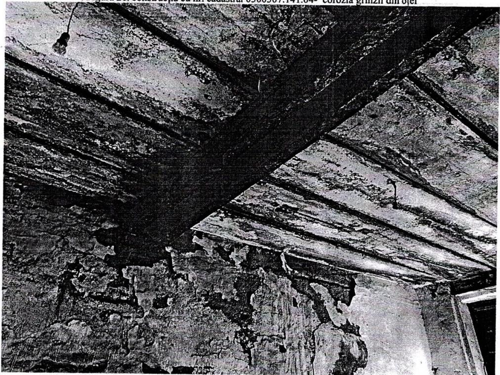
Figura 22. construcția cu nr. cadastral 0300307.141.04- deteriorarea zidăriei
