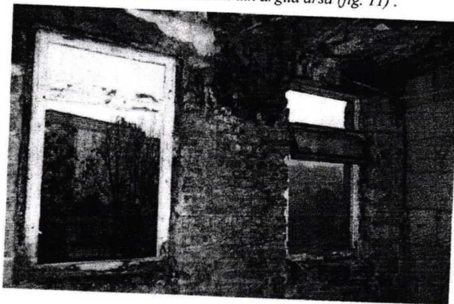
Fig. 11. Aspectul intergolului realiza din zidăriei din cărămidă din argilă arsă.
