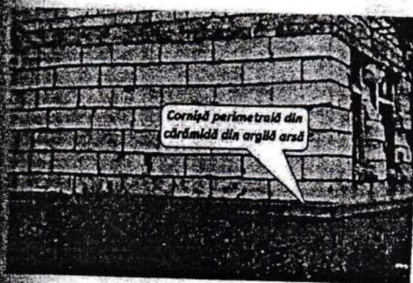
Fig. 10. Aspectul cornișei din cărămidă, care servește în calitate de pat pentru zidărie.
