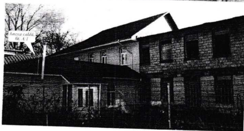
Fig. 5. Aspectul exterior (fațadele) anexei calde, nr. cadastral: 0300208.102.01, lit. A/1 (galerie de trecere, anexată la construcția de bază, lit. A/2) și anexei calde, nr. cadastral: 0300208.102.01, lit. A/3 (cazangerie, anexată la construcția de bază, lit. A).
