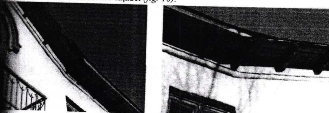
Fig. 15. Localizarea căptușelii din lemn al acoperișului degradată
