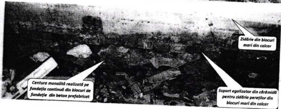
Fig. 9. Aspectul din interiorul clădirii a centurii monolite, realizate deasupra fundației continue din blocuri de fundație din beton prefabricat cu strat egalizator din cărămidă din argilă arsă, executat în calitate de pat pentru blocurile mari din calcar a zidăriei pereților structurali.
