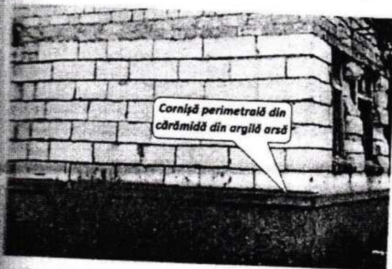
Fig. 10. Aspectul cornișei din cărămidă, care servește în calitate de pat pentru zidărie.
