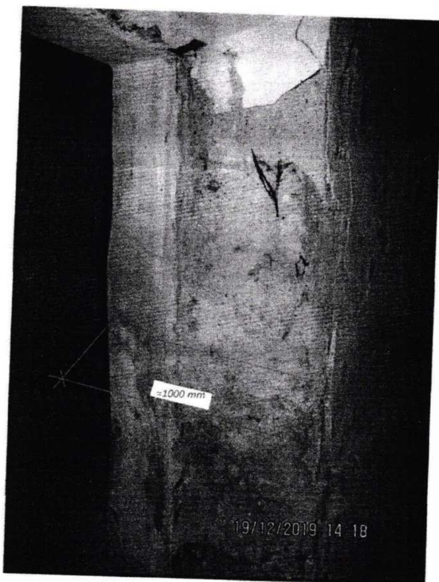
Fig. 6. Aspectul peretelui portant (central) din spațiul demisolului.
