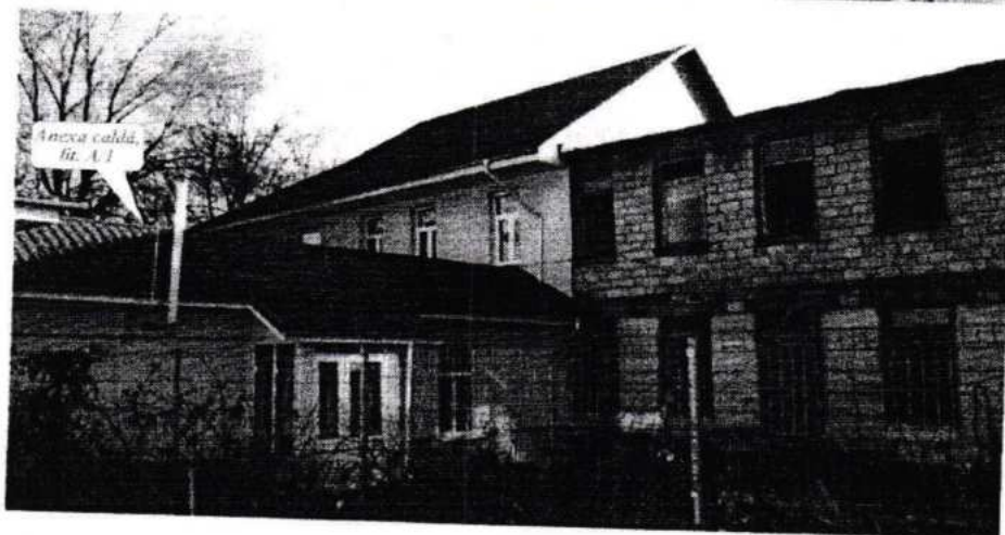
Fig. 5. Aspectul exterior (fațadele) anexei calde, nr. cadastral: 0300208.102.01, lit. A/1 (galerie de trecere, anexată la construcția de bază, lit. A/2) și anexei calde, nr. cadastral: 0300208.102.01, lit. A/3 (cazangerie, anexată la construcția de bază, lit. A).
