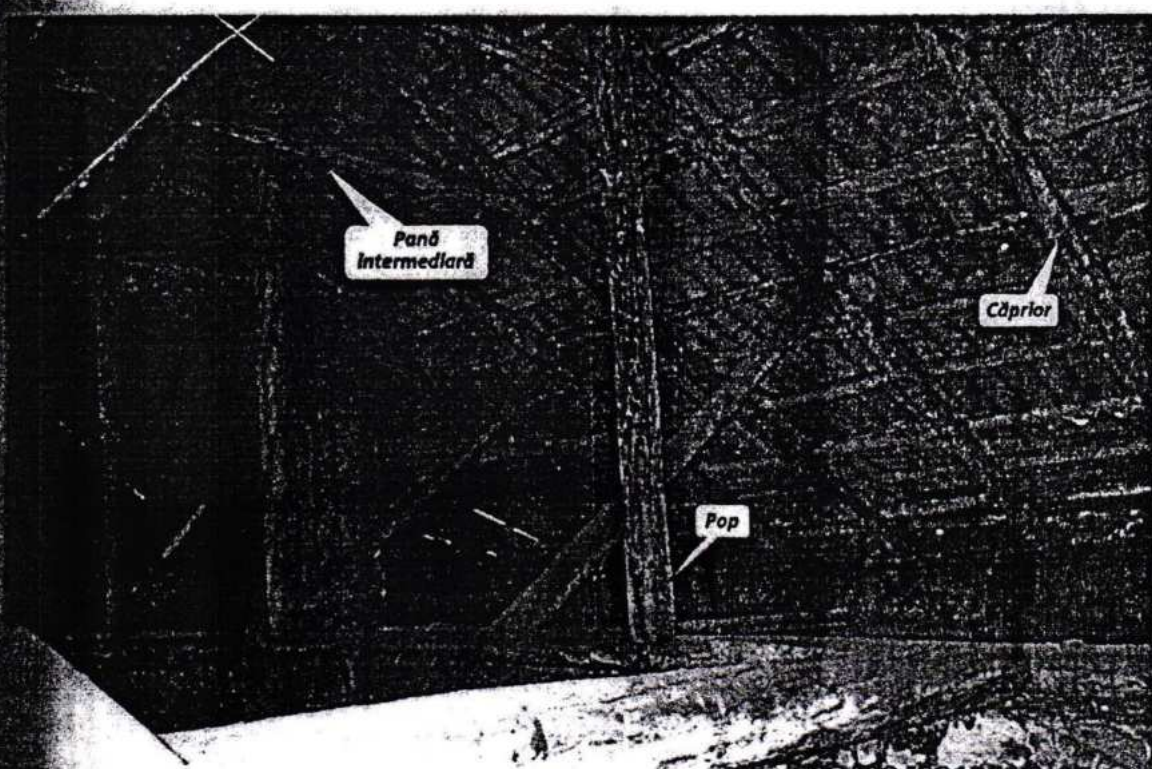
Fig. 13. Elementele structurii de rezistență al acoperișului șarpantă.
