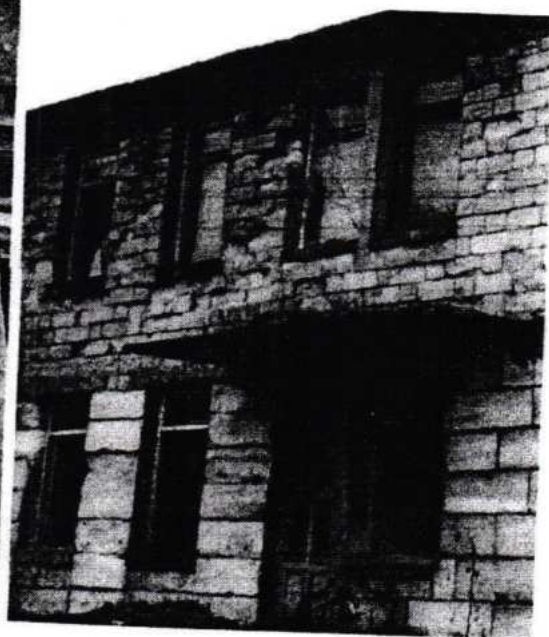
Fig. 17. Aspectul zidăriei peretelui exterior (portant), degradat în urma eroziunii fizice.
