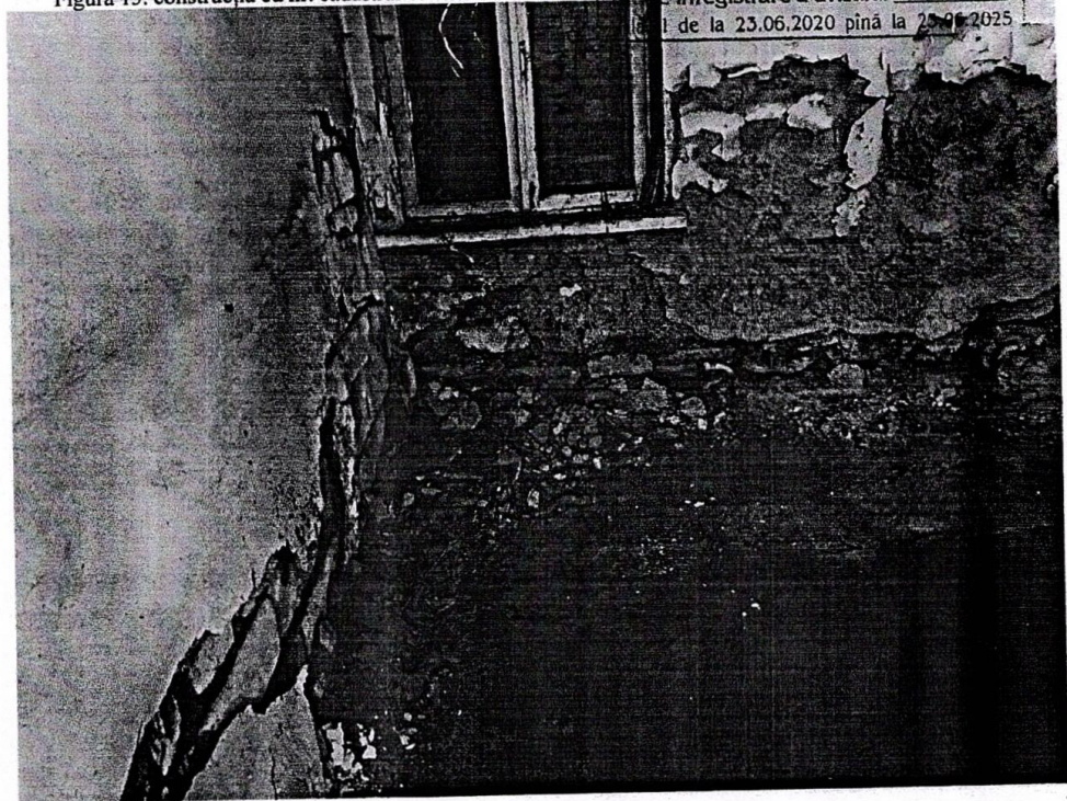
Figura 15. construcția cu nr. cadastral 0300307.141.03-zidărie necorespunzătoare, demolarea tencuielei
