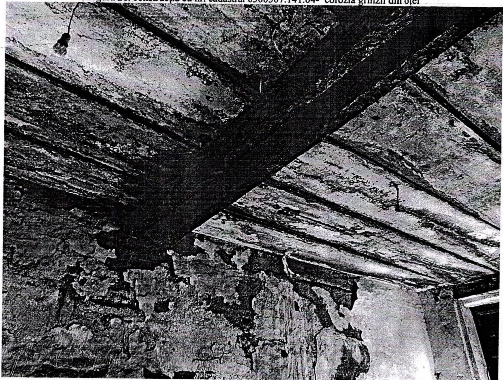
Figura 21. construcția cu nr. cadastral 0300307.141.04- coroziia grinzii din oțel
