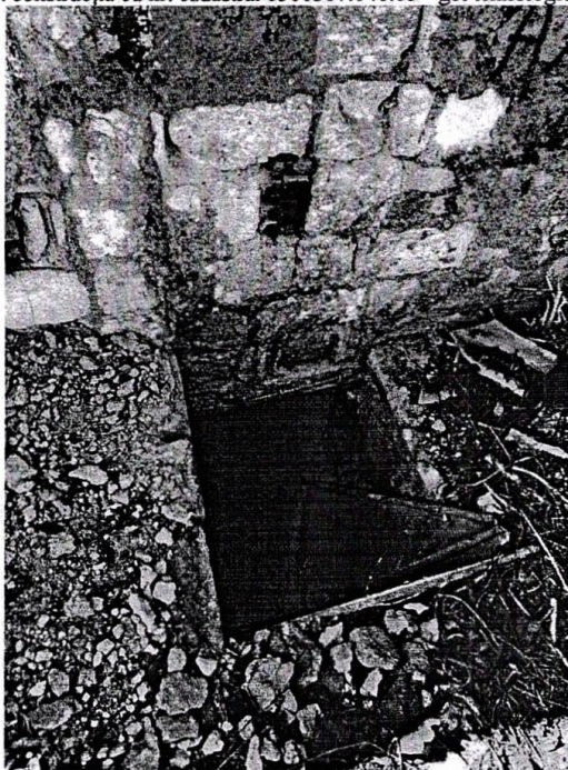
Figura 29. construcția cu nr. cadastral 0300307.141.05- planșeu montat pe direct pe zidărie, lipsa tencuielei și pereului
