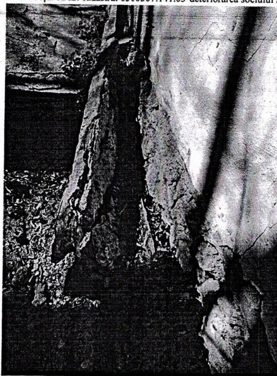
Figura 5 construcția cu nr. cadastral 0300307.141.03-deteriorarea soclului și pereului
