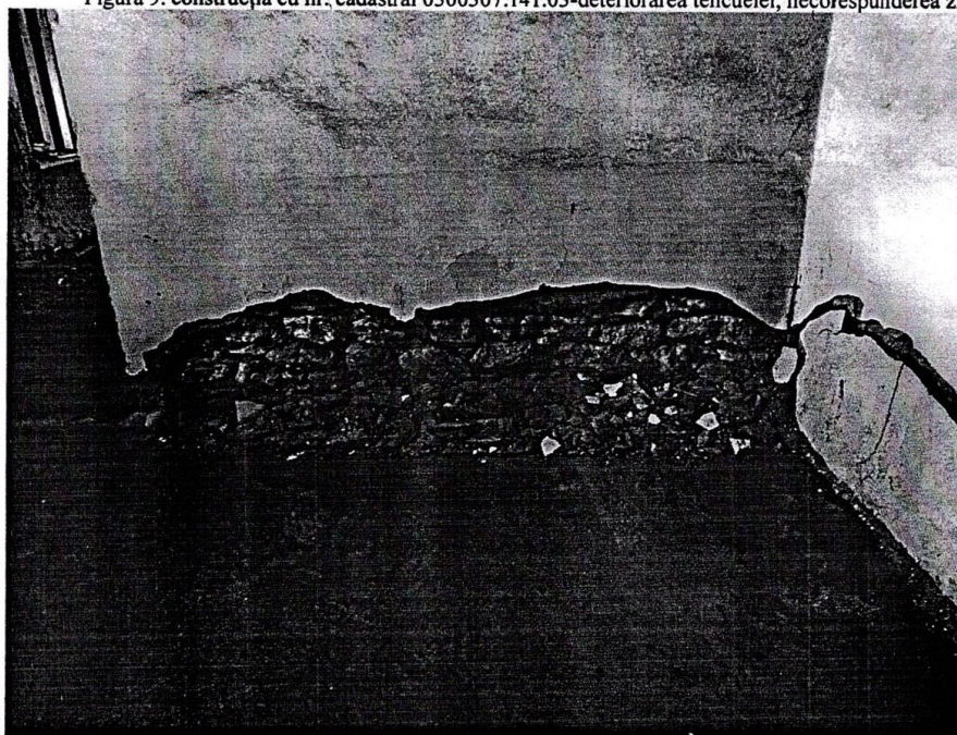
Figura 9. construcția cu nr. cadastral 0300307.141.03-deteriorarea tencuei, necoresponderea zidăriei
