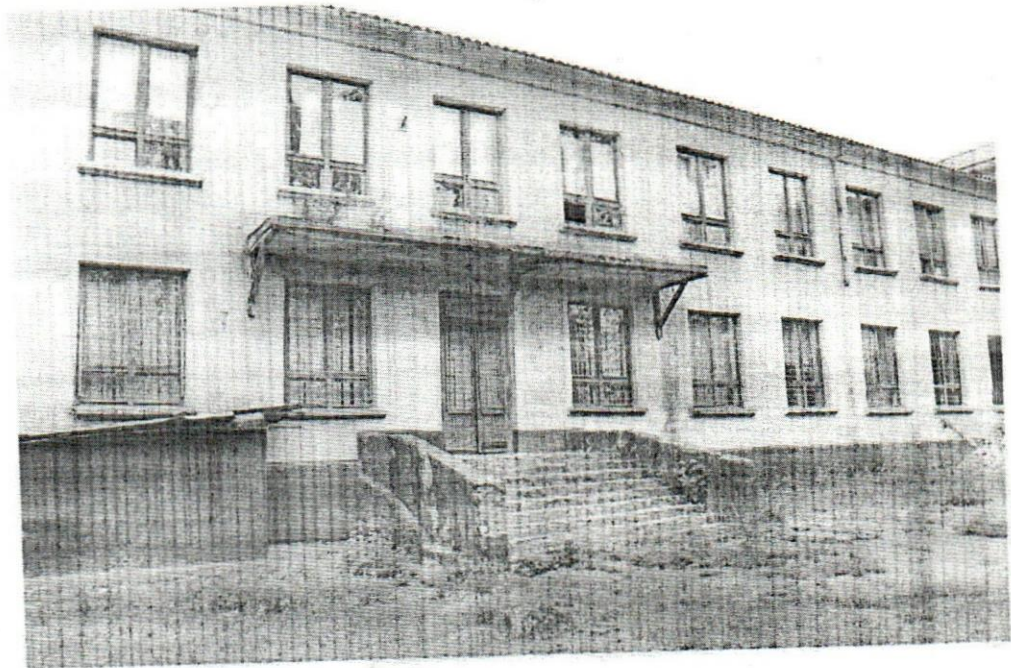
Imaginea nr. 25: Intrarea centrală în Gimnaziul „A.I.Cuza”. Actualmente neutilizată din cauza pragului deteriorat, acoperișului acestuia și terenului neamenajat Sursa: Vizite de observare (septembrie 2018 – februarie 2019)
